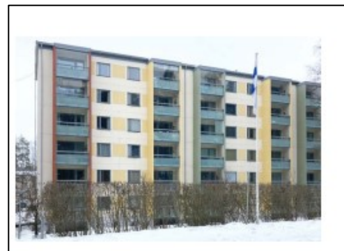
Lentävänniemessä parvekkeet ovat perinteisesti kapeissa vyöhykkeissä. Kuva: Inaro Oy
