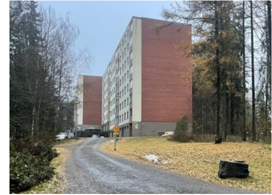
Tiilipinnat säilytetään julkisivukorjauksissa. Kuva: Tampereen kaupunki.
